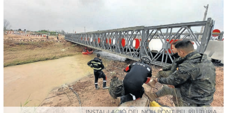
INSTAL·LACIÓ DEL NOU PONT PEL RIU TÚRIA.
