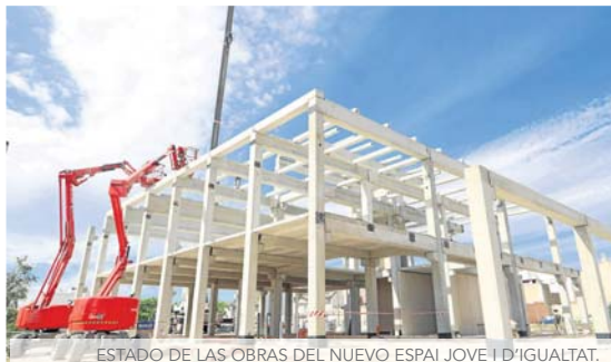
ESTADO DE LAS OBRAS DEL NUEVO ESPAI JOVE I D'IGUALTAT.
